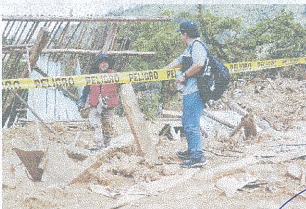
Fotografía 5: Inspección de inmuebles inventariados.
