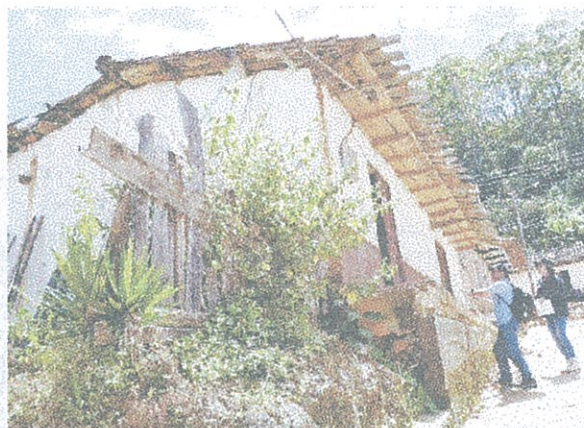
Fotografía 4: Inspección de inmuebles inventariados.
