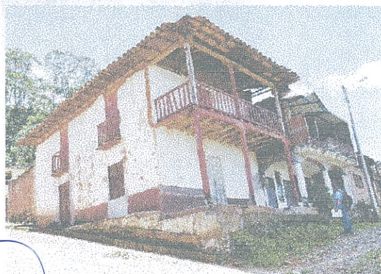
Fotografía 6: Inspección de inmuebles inventariados.
