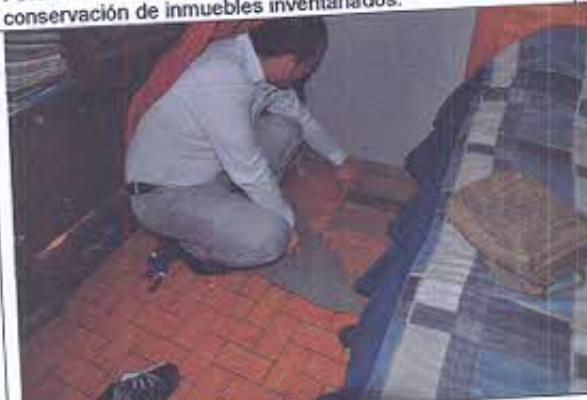
Foto 10: Inspección a inmueble IBI-19-07-50-000-000001.
