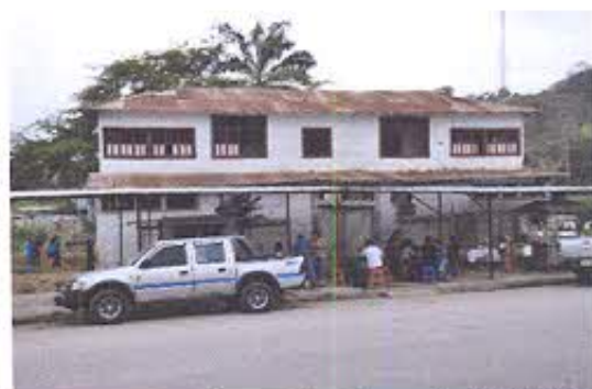
Fotografía nro. 2: Inspección al inmueble IBI-07-02-50-000-000002, Antiguo Hospital de Arenillas.
