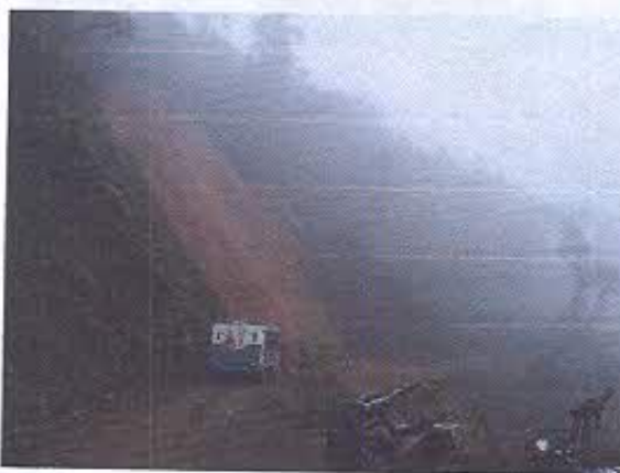
Foto 1.- Vista de la vía hacia el sector de El Planteado
