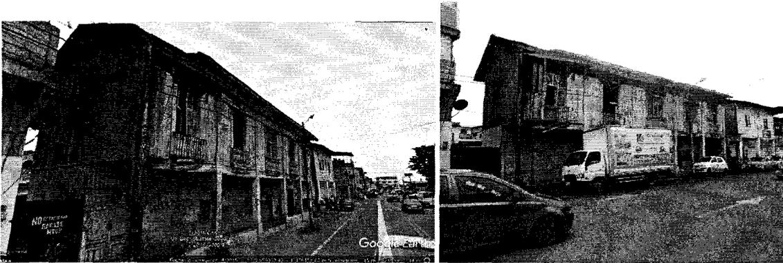
Fachada frontal se evidencia el deterioro de la madera que conforman las paredes
