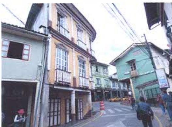
Fotografía nro. 1: Inmuebles inspeccionados calle Bolívar.
