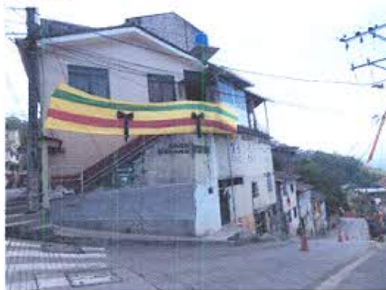
Fotografía nro. 4: Inmuebles inspeccionados calle Luis A. Crespo.
