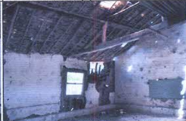
Foto 6: Detalle de estructura de cubierta
