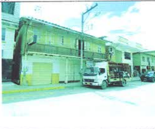
Fotografía nro.6: Inspección de de Biene inmueble, IBI-07-11-50-000-000093 cabecera cantonal Portovelo, El Oro.
