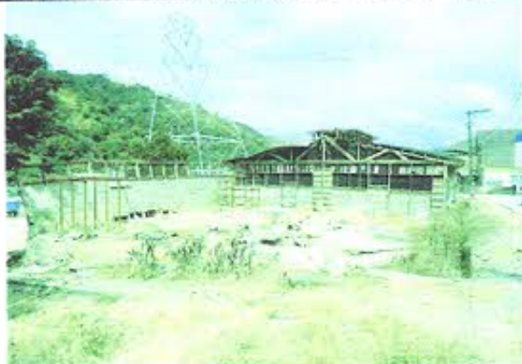
Fotografía nro.1 : Inspección inmueble IBI-07-11-50-000-000109, Antigua Bodega SADCO.
