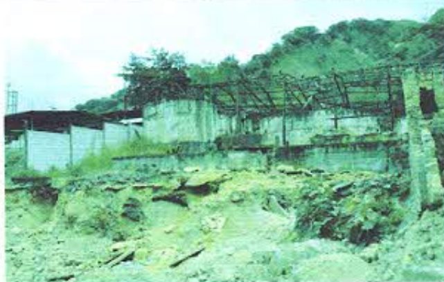
Fotografía nro.2: Inspección inmueble IBI-07-11-50-000-000143, Antigua SADCO.
