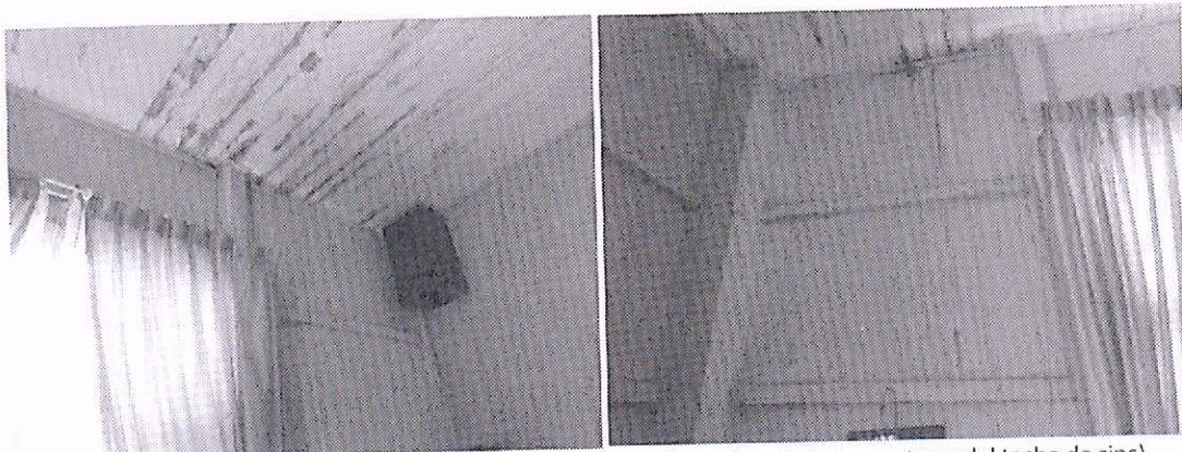
Interior de la edificación sus deterioros por filtración de aguas lluvias (movimiento y roturas del techo de zinc).
