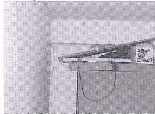
Vistas del interior de una bodega adjunta a la caja de escaleras y fisuras entre la viga de la losa y la mampostería.
