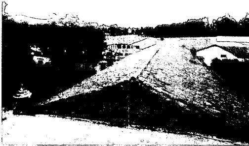
Unión de bóveda con muro, filtración por el albañal exterior e interior
