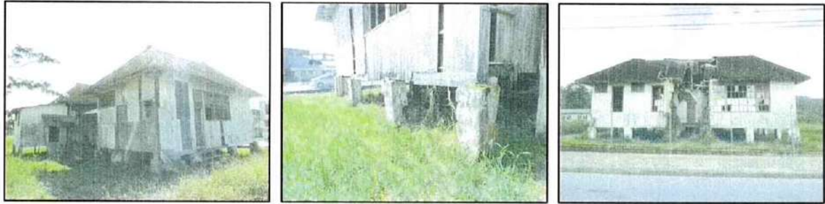
Estado actual del bien inmueble
