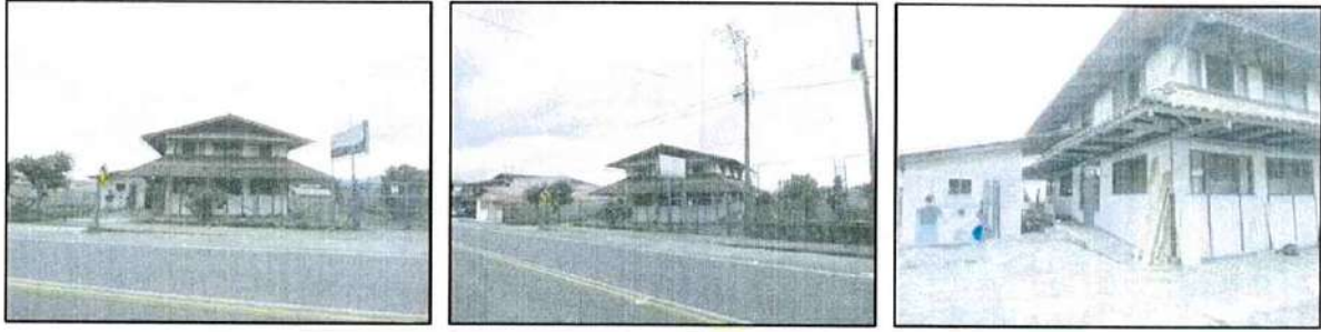
Estado actual del bien inmueble
