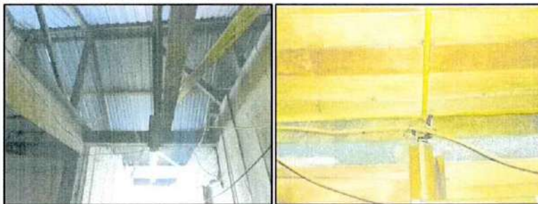
Estado actual del bien inmueble
