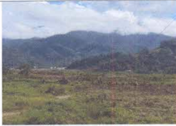
Foto 5.- Parte baja del área de relaves en donde se encuentran maquinaria realizando remoción de suelo
