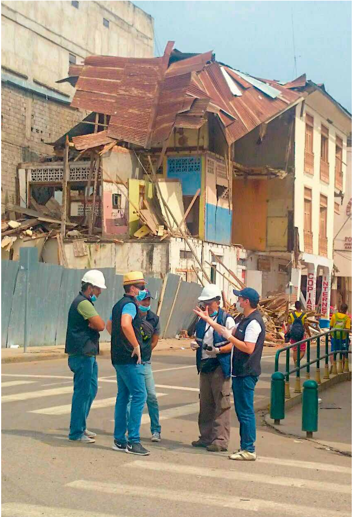
Inspección de técnicos INPC R4 después del terremoto - Manabí
