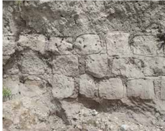
▲ Muro de tapia en San Pablo
